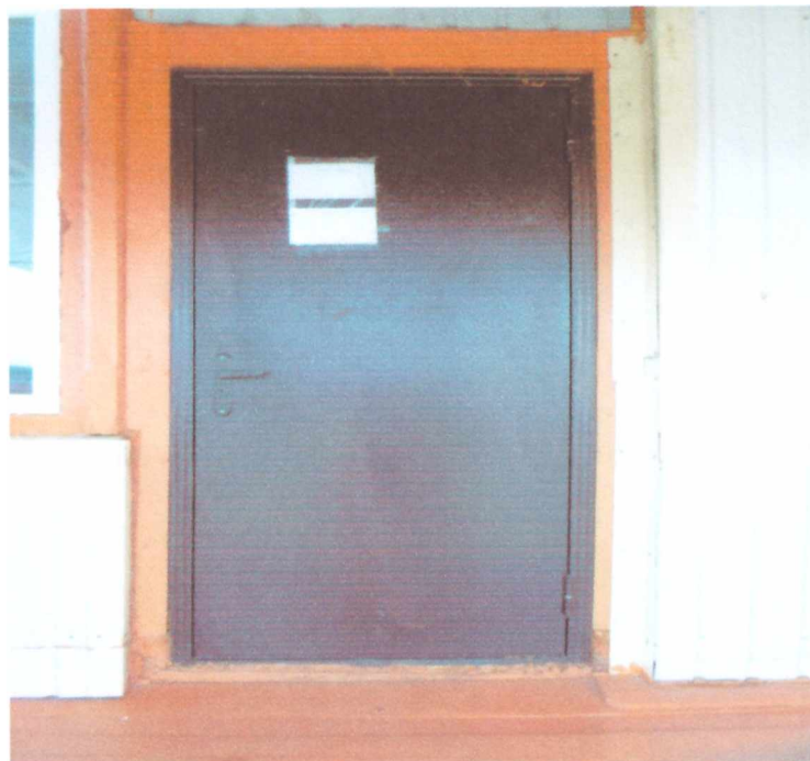
Фото № 10 Дверь входная (1,2,3)
