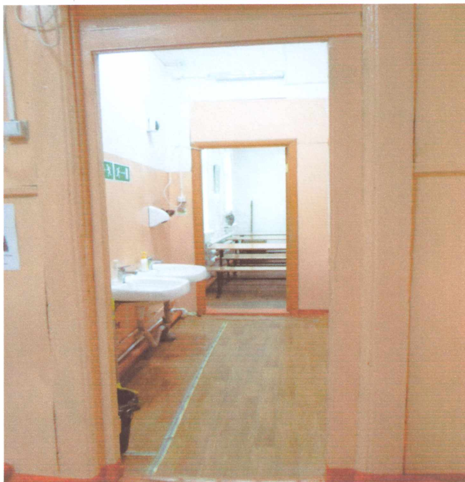
Фото № 19 Пути эвакуации
